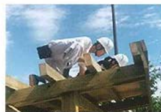
福崎公園バス停の作業風景：滋賀県立大学
