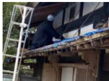
古民家の改修
