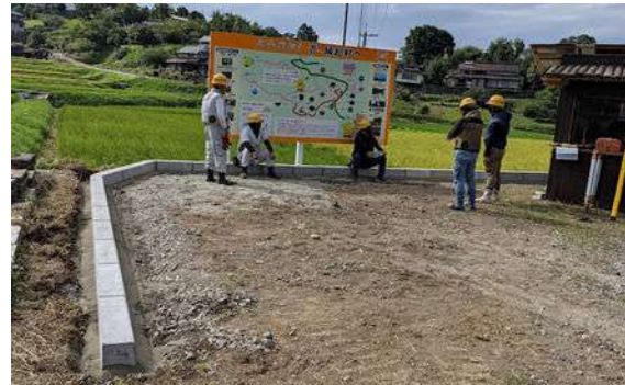
駐車場・イベント広場
